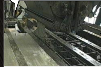
Puesta en obra en el molde
