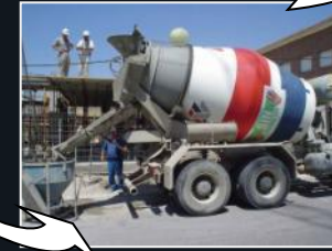
Suministro del hormigón
